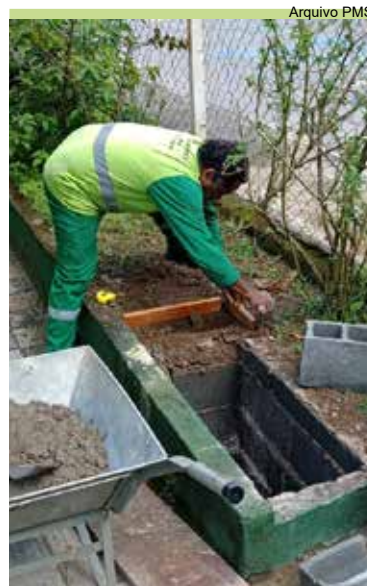
Reparo em caixa de drenagem na Policlínica do Monte Cabrão
