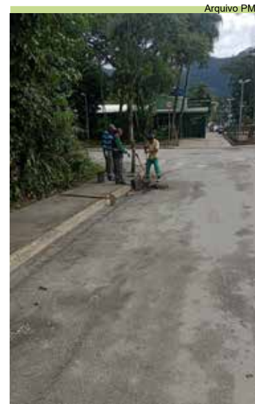
Conserto de caixa de drenagem na Rua Andrade Soares
