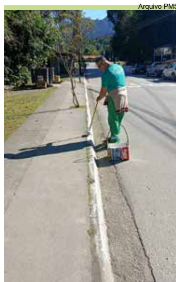
Pintura de guias e postes da Rua Andrade Soares, no Caruara
