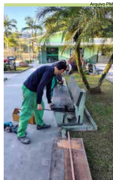
Troca dos assentos dos bancos da Praça Encarnación Alves Corpaz
