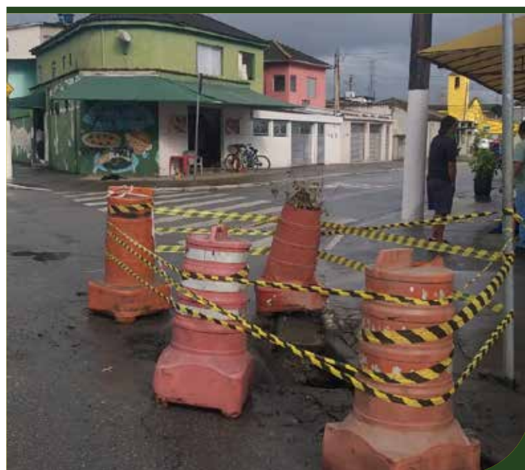
Manutenção asfáltica no entorno de boca de lobo: Praça Nicolau Geraigire com Rua Professor Francisco Meira
