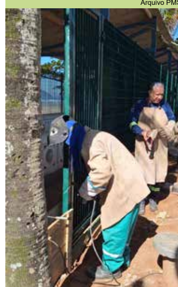
Instalação de gradis e portões na quadra de bocha no Emissário
