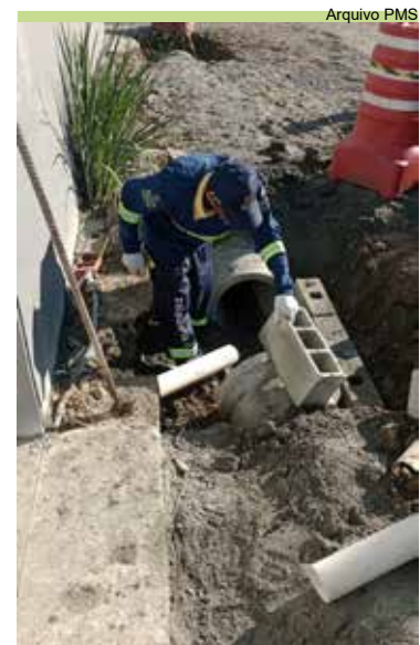
Construção de caixas de passagem na Rua 1, no Caruara
