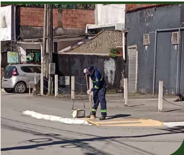
Continuação da pintura das guias e sarjetas da Rua Andrade Soares, no Caruara
