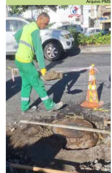
Troca de poço de visita na Praça José Domingues Martins, na Aparecida
