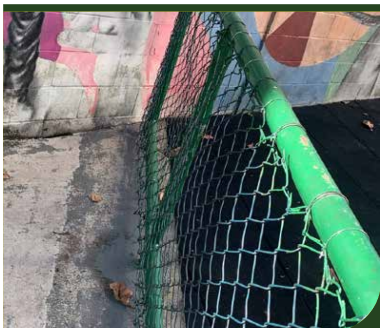
Conserto de alambrado no playground da Praça Nova Era, na Vila Sapo, na Ponta da Praia
