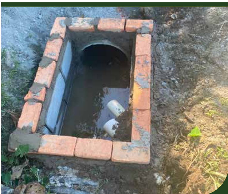
Limpeza de caixas de drenagem na Rua 2, no Caruara
