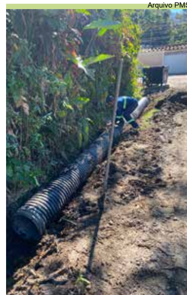
Instalação de manilhas na Rua 2, no Caruara
