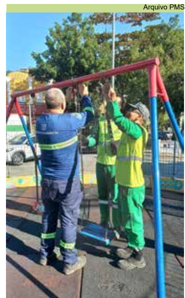
Instalação de balanços na Praça Cândido Portinari, no Marapé
