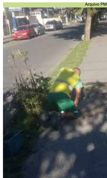
Conserto de calçada na Avenida Joaquim Montenegro, Canal 6
