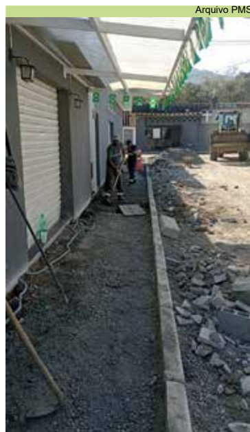
Instalação de guias e preparação para concretar a calçada da Rua 1
