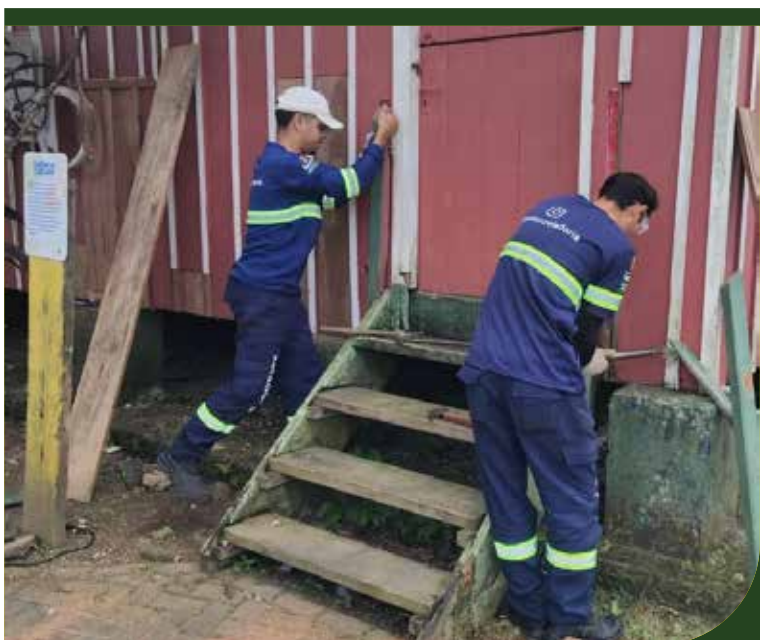
Continuação dos trabalhos de manutenção na Escola em Tempo Integral, no Caruara
