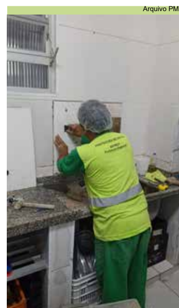
Reparo no revestimento da UME Monte Cabrão
