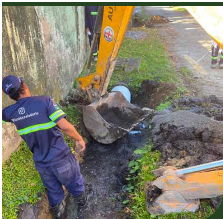
Continuação do serviço de instalação de manilhas na Rua 2, no Caruara
