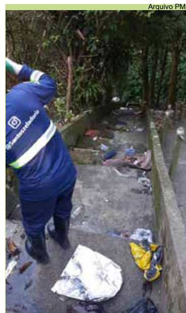
Limpeza de caixas, escada hidráulica e canaletas no Morro José Menino
