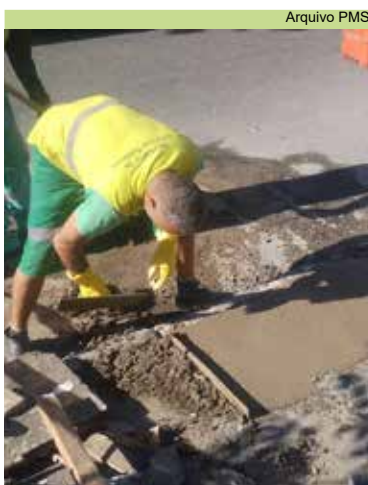
Colocação de tampa de concreto na Av. Afonso Pena
