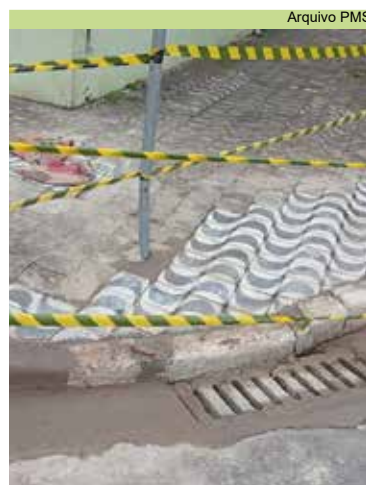
Reparo em calçada: Alfredo Albertini e 9 de Julho, no Marapé
