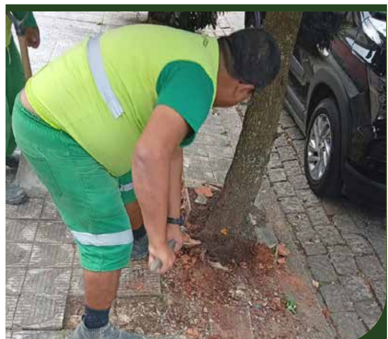
Abertura de berço e conserto de calçada na Rua Visconde de Farias, número 216, no Campo Grande
