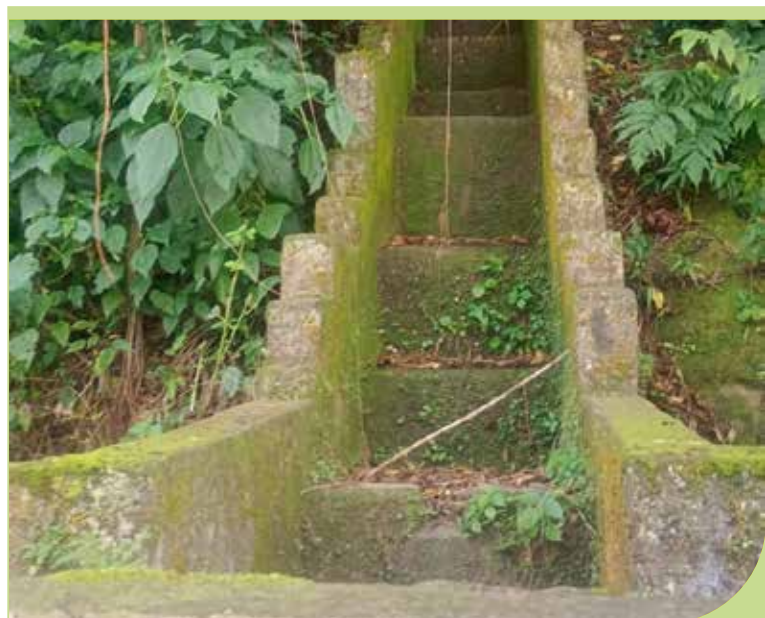
Limpeza de canaleta, caixa e escada hidráulica na Rua Nilo Peçanha, no Morro Marapé
