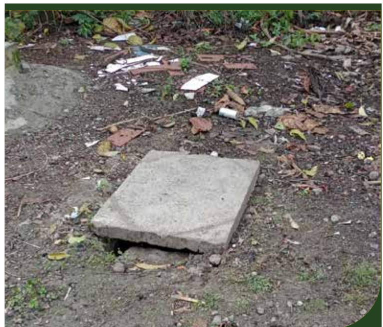
Colocação de tampa de concreto na Rua Santo Antônio
