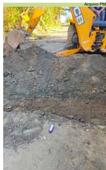
Instalação de tubo de drenagem na Rua João Torres
