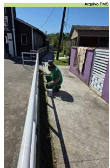
Serviço de pintura de equipamentos na Ilha Diana
