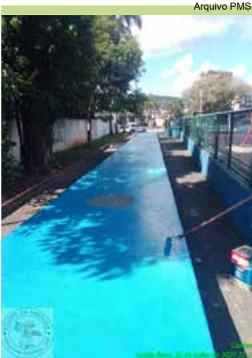
Pintura e demarcações das linhas na quadra de malha na Praça Bruno Barbosa
