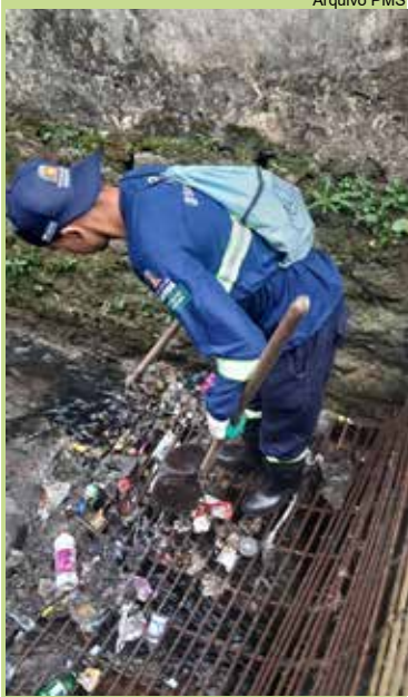
Limpeza de caixas na Rua Bandeirantes, na Vila São Bento, no Morro São Bento
