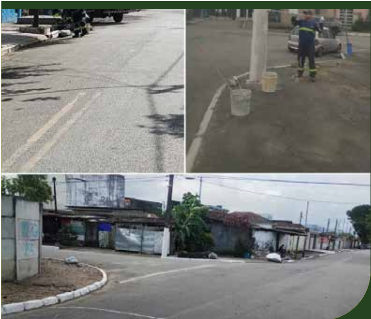
Pintura de postes e guias em trecho da Rua Maj. Arthur A. Firmino, entre os números 250 ao 312, no Rádio Clube
