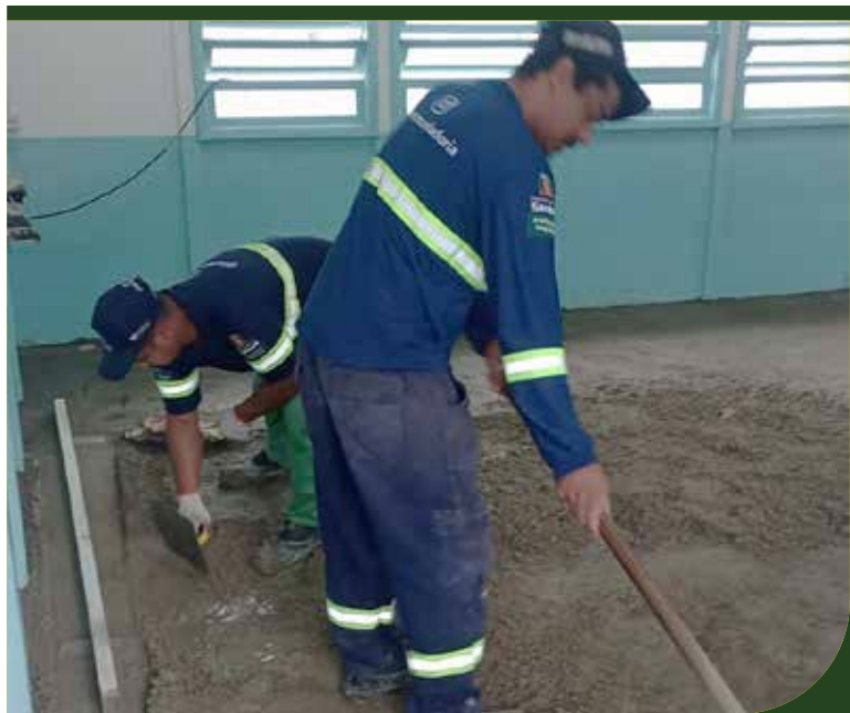
Continuação do nivelamento do piso da sala de aula na UME Judoca Ricardo Sampaio
