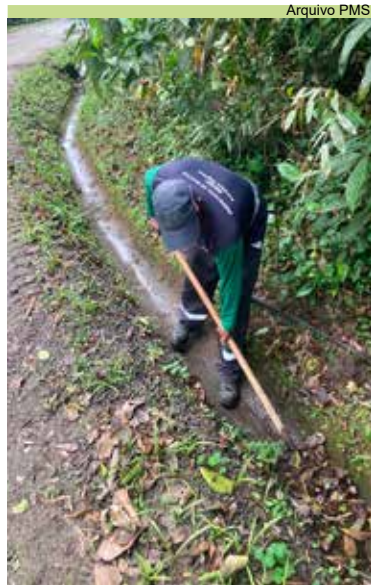
Limpeza de canaletas na Travessa Antônio Mineiro
