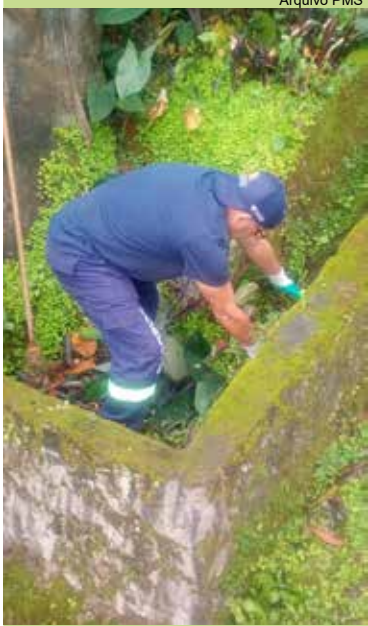
Serviço de limpeza de canaletas e caixas Rua 6, no Morro Marapé
