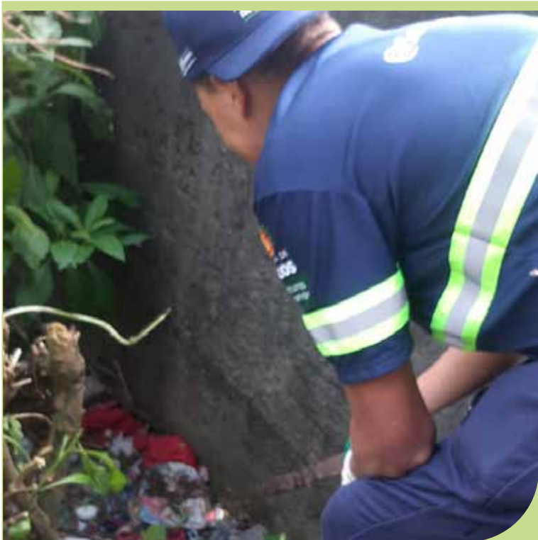
Limpeza de grelhas, canaletas e caixas na Praça do Riquinho, no Morro São Bento
