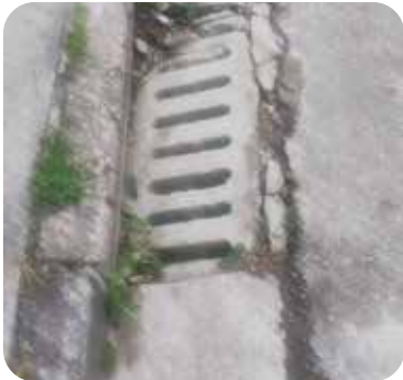
Trinca da tampa e vedação do poço de visita na Rua Eduardo Alves, em frente ao número 160, no São Jorge
