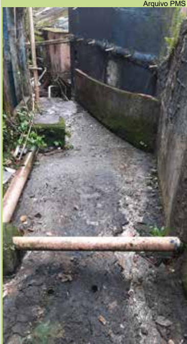
Limpeza de caixas no Beco do Asilo dos Inválidos, no Nova Cintra
