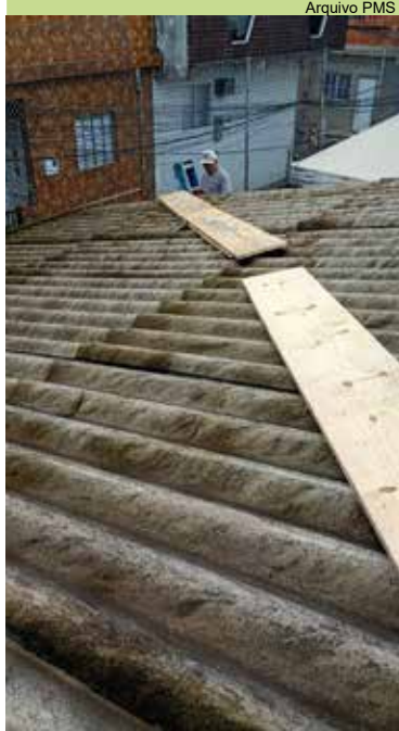
Reparos no telhado da antiga Policlínica da Vila Progresso,
