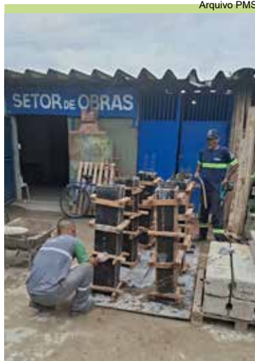
Reforçada produção de novas muretas Padrão Santos
