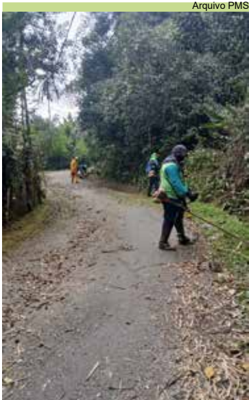
Serviço de roçada nas Rua Xavantes e Travessa Antônio Mineiro
