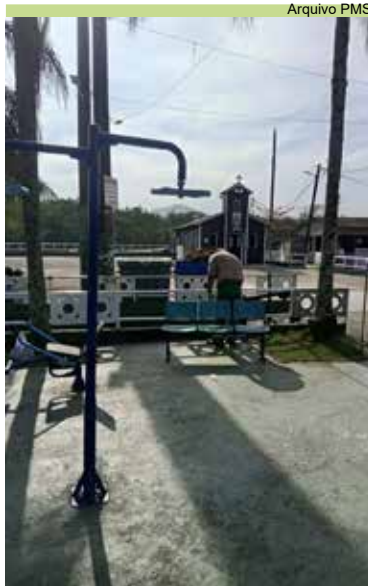
Serviço de pintura equipamentos na Ilha Diana
