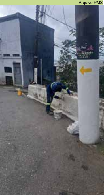
Pintura de guias, postes e muretas na Avenida Santo Antônio do Valongo
