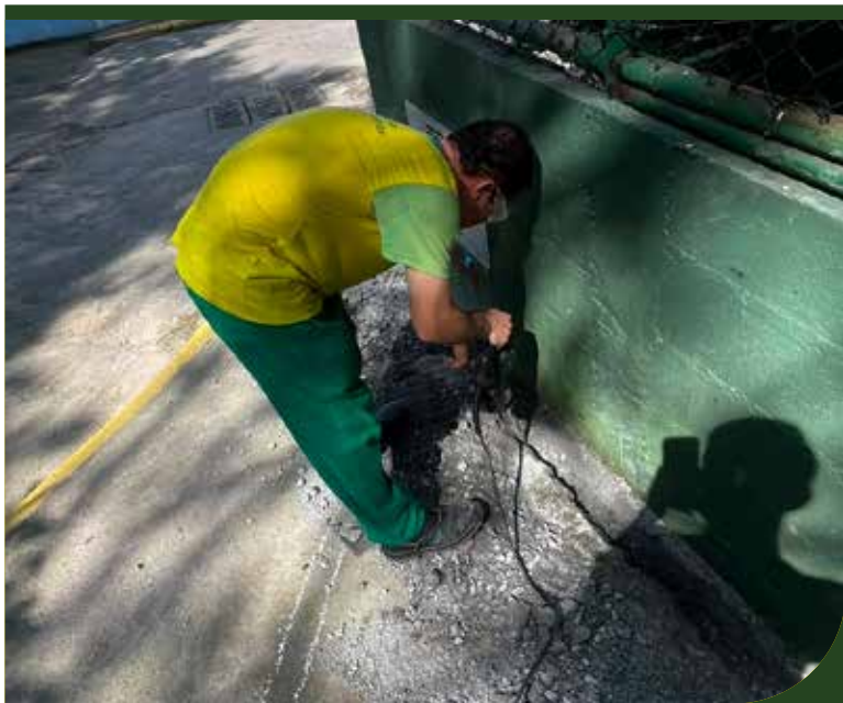
Ligação hidráulica para adequação do relógio de marcação de água
