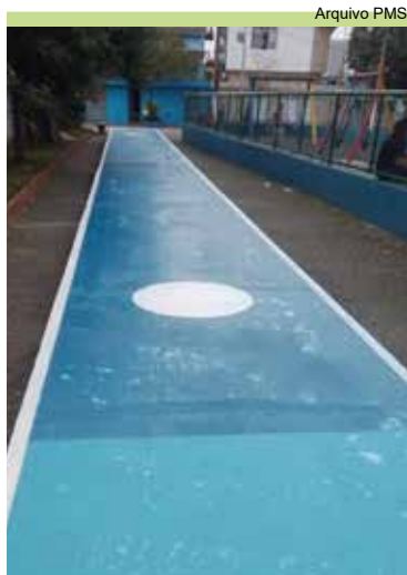
Demarcações das linhas e aplicação de resina na quadra de malha na Praça Bruno Barbosa
