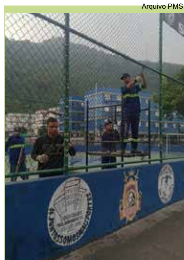
Vila São Jorge: reparos no alambrado de quadra na Praça Prestes Maia
