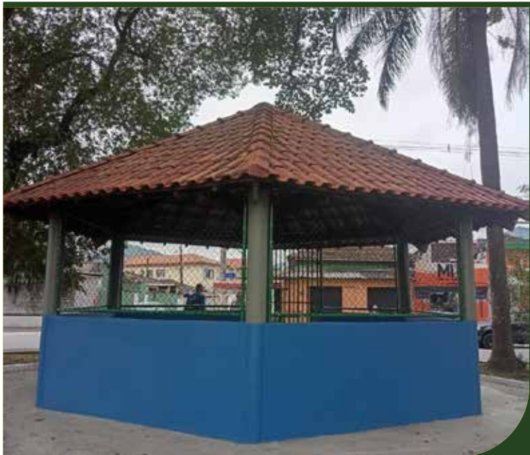
Conclusão da instalação do alambrado no quiosque da Praça Francisco de Marchi (Praça do 14), no Castelo
