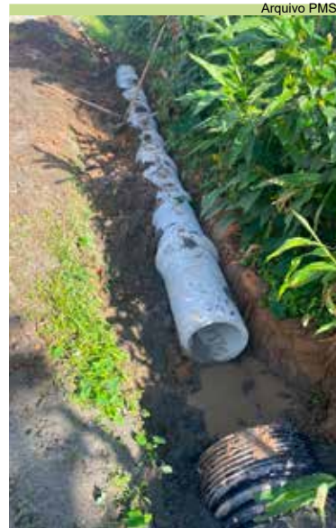
Continuação da instalação de manilhas na Rua Tapuia, no Caruara
