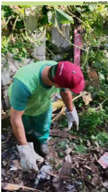
Limpeza de resíduos na Rua 1, no Morro Boa Vista
