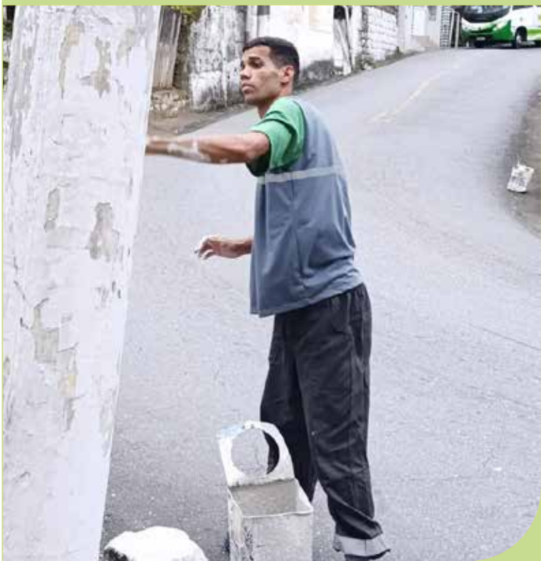
Pintura de guias e postes na Rua São Cristóvão, no Morro São Bento
