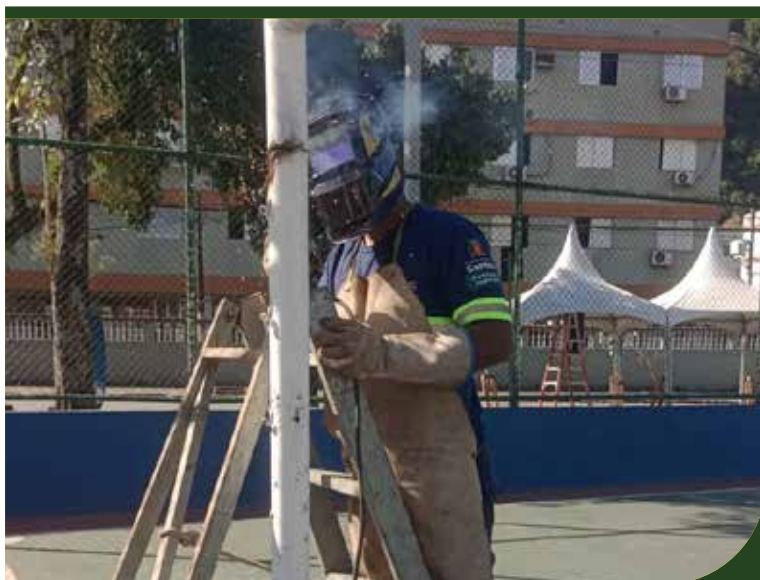
Reparos nas traves e no alambrado da quadra esportiva da Praça Engenheiro Prestes Maia, na Vila São Jorge
