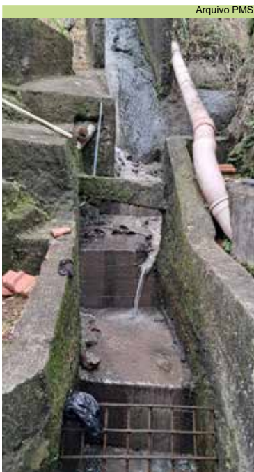
Limpeza de caixas e da escada hidráulica na Rua 13
