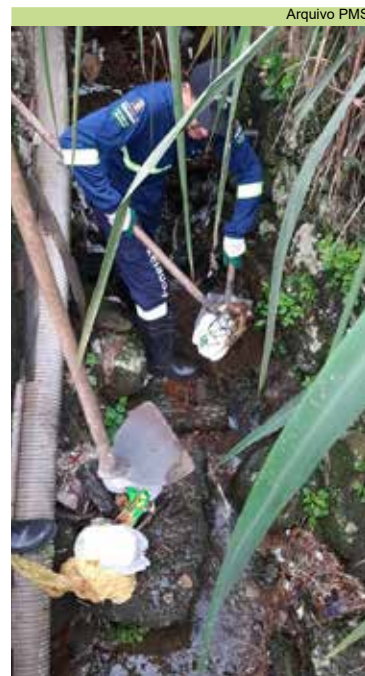
Limpeza de vala na Rua 9, no Morro Pacheco
