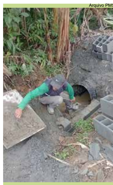
Colocação de caixa de passagem na Rua Tapuia
