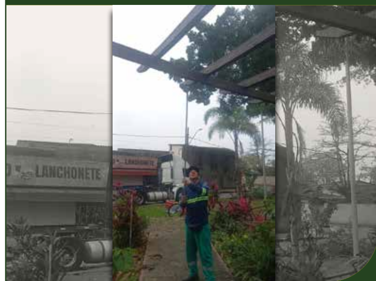
Pintura do pergolado e arremates no quiosque, no Recanto da Rua Etelvina de Paula Freire, no Piratininga
