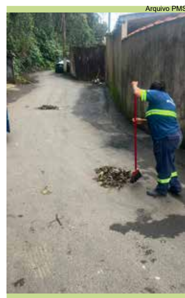
Realização de serviço de limpeza na Rua Principal
