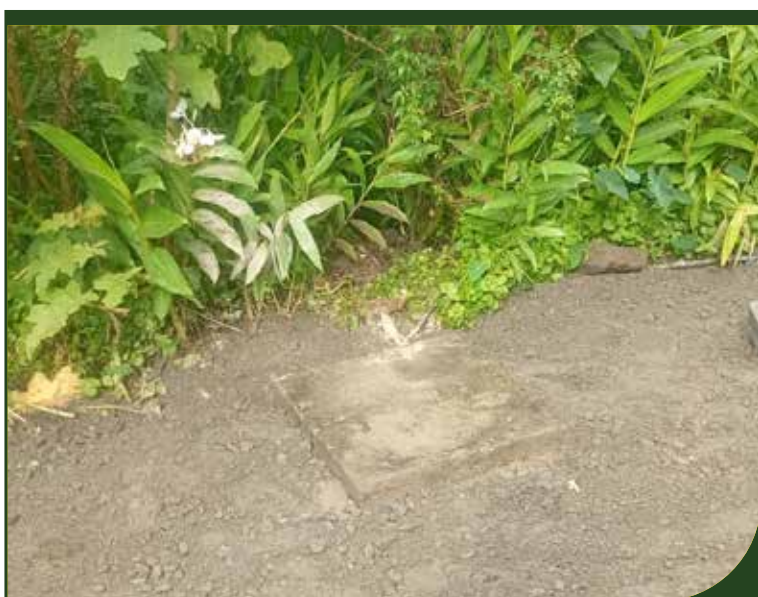
Instalação de caixa de passagem e de tampa de concreto na Rua 2, no Iriri Baixo
