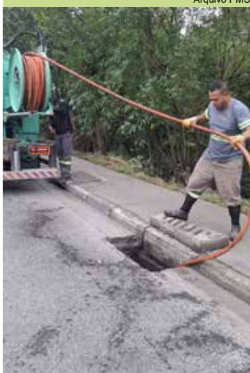
Limpeza do sistema de drenagem da Rua Julia Ferreira de Carvalho
