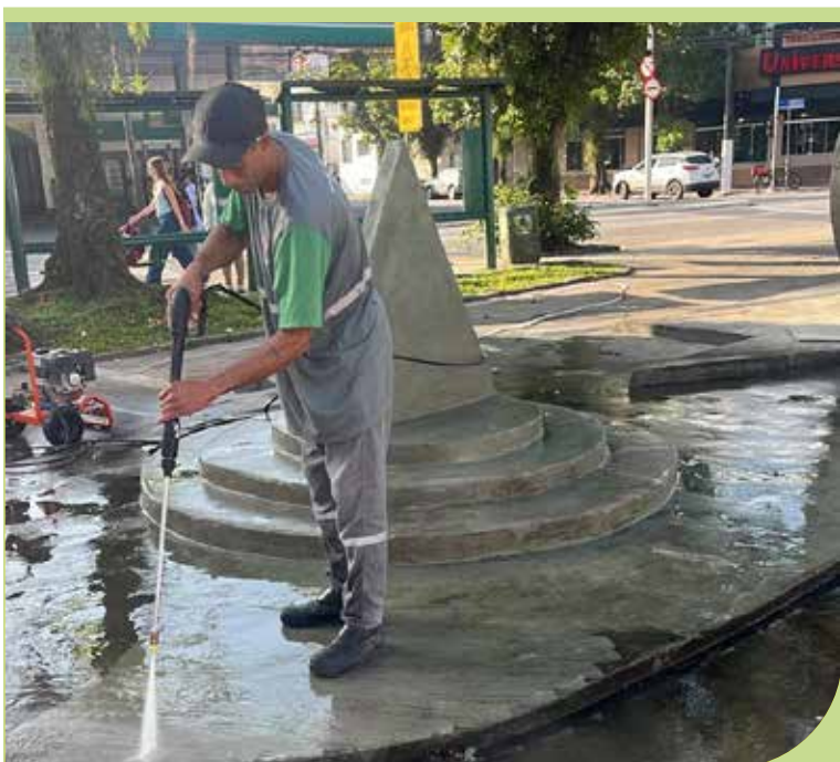
Zeladoria fez reparo e lavagem em monumento da Praça Almirante Tamandaré, na Encruzilhada
