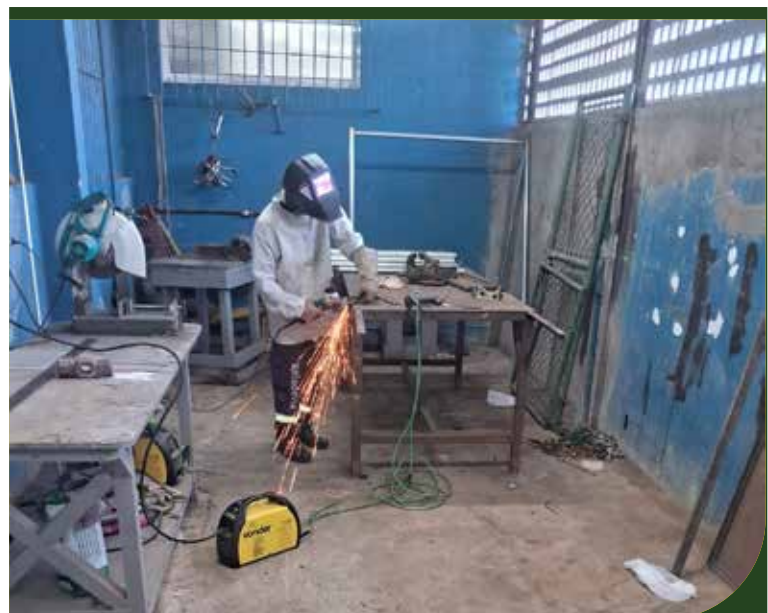
Realizados serviços de solda para instalação de corrimão no Monte Serrat
