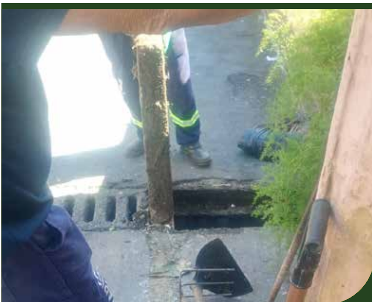
Canaletas da Rua Nossa Senhora dos Anjos ganharam manutenção
