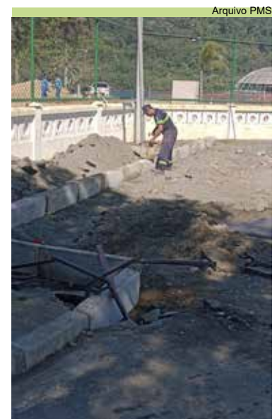
Instalação de guias na Coordenadoria Técnica
