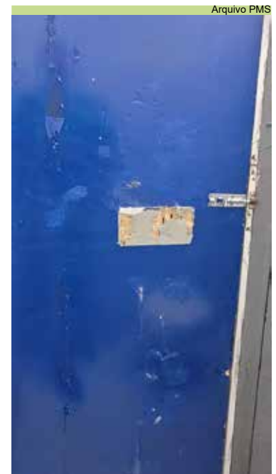
Colocação de porta no banheiro masculino do Canal 5
