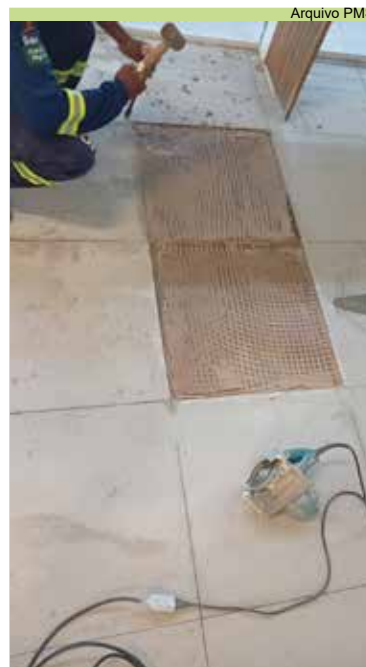
Reparo no piso cerâmico no Mercado de Peixe, na Ponta da Praia
