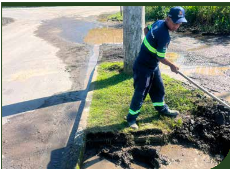
Limpeza de caixa de passagem na Rua Principal, no Monte Cabrão
