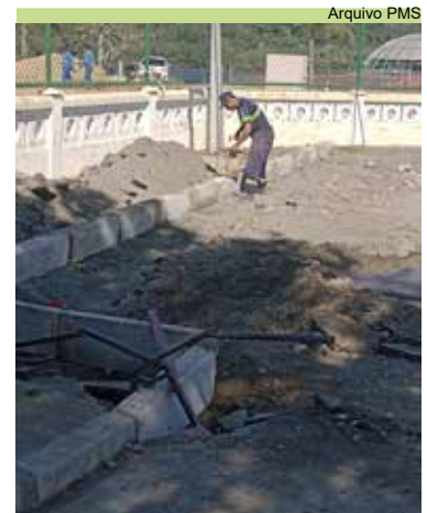
Instalação de guias na Coordenadoria Técnica
