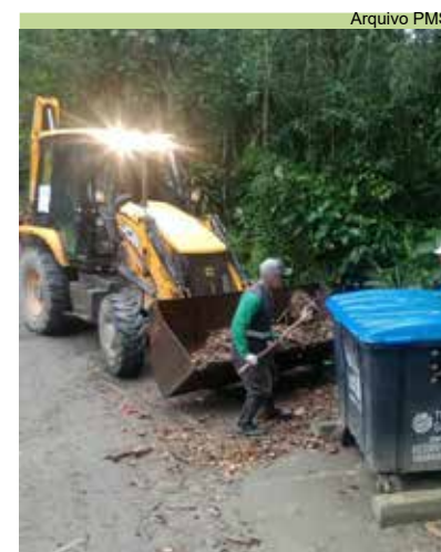
Realização de serviço de cata-treco no Caruara
