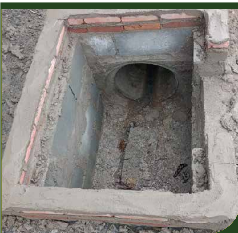
Construção de caixa de passagem na Rua Tapuia, no Caruara
