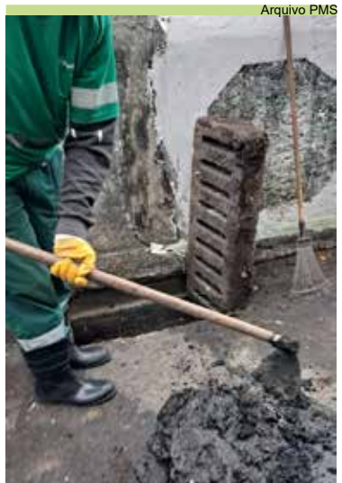
Morro José Menino: limpeza de grelhas e caixas na Rua 6
