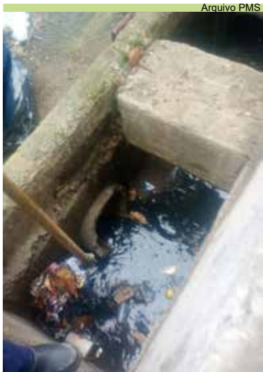
Serviço de limpeza de caixas na Vila Telma
