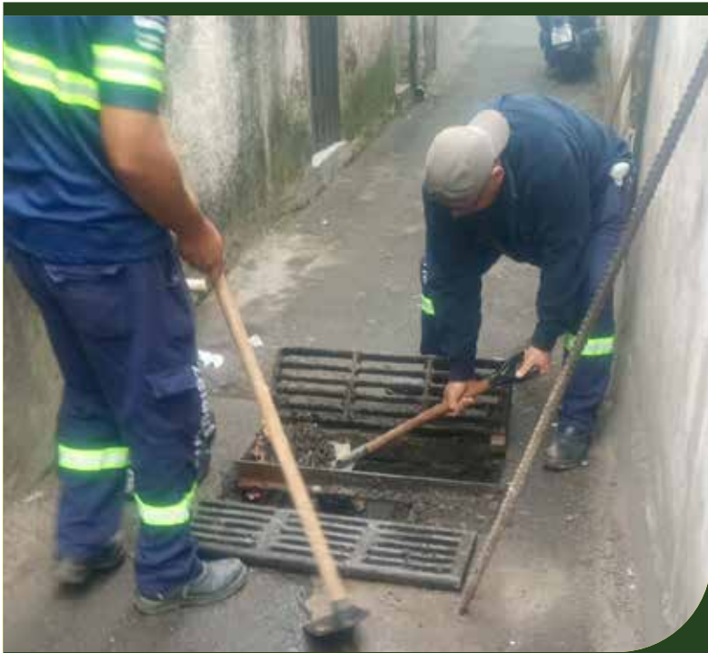
Serviço de limpeza de grelhas na Vela Dona Geruza, na Vila Progresso
