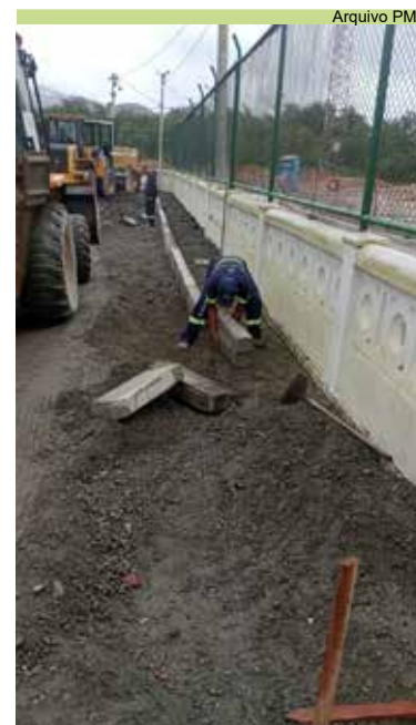
Instalação de guias na Coordenadoria Técnica
