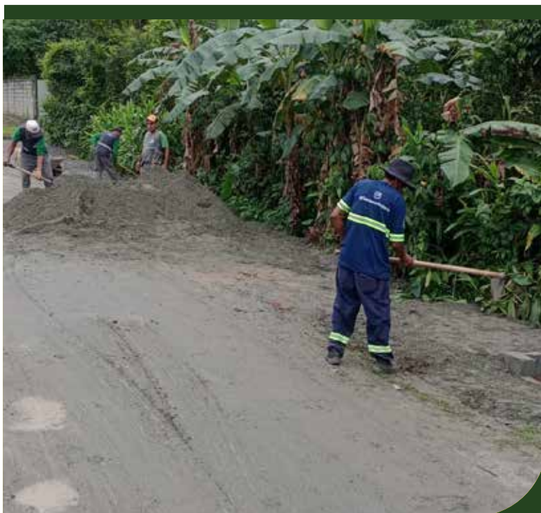
Nivelamento de calçada na Rua Tapuia, no Caruara
