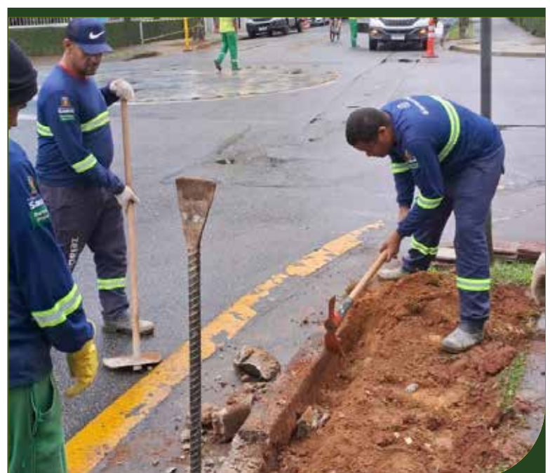
Construção de rampa de acessibilidade: ruas Aureliano Coutinho e Professor Antenor Bué
