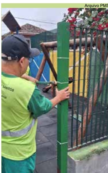
Manutenção em grade de praça na Rua Engenheiro José Garcia da Silveira
