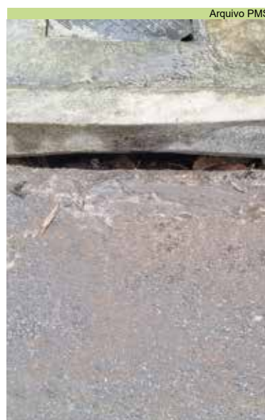
Conserto em boca de lobo na Rua Egydio Martins, 198, na Ponta da Praia
