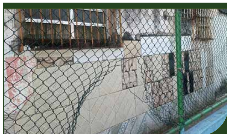
Vistoria Técnica para realização de reforma no alambrado da quadra esportiva na Rua Vitelbino Ferreira de Souza
