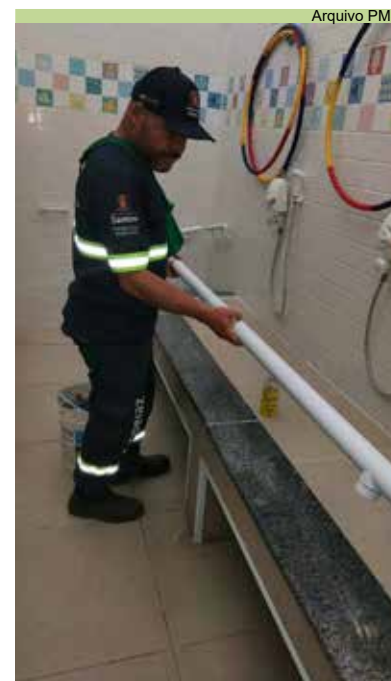
Instalação de corrimão na UME Noel Gomes Ferreira
