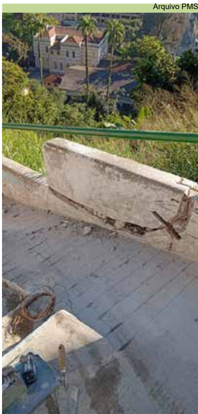
Monte Serrat: recuperação de mureta no Caminho M. Moreira, Nicho 5
