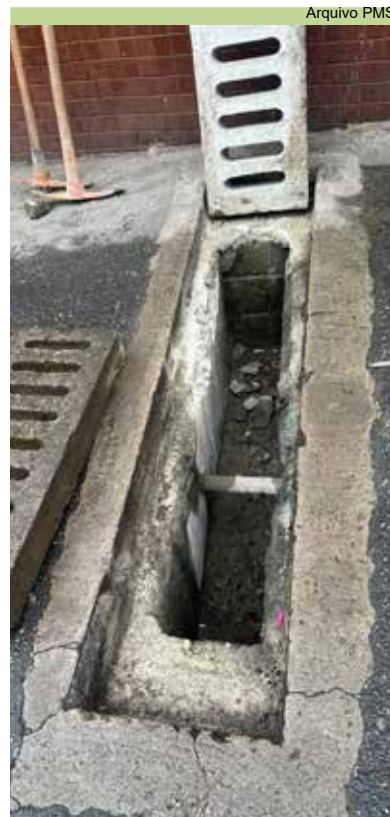
Reparos e troca de grelhas na Rua São Marcos, no São Bento
