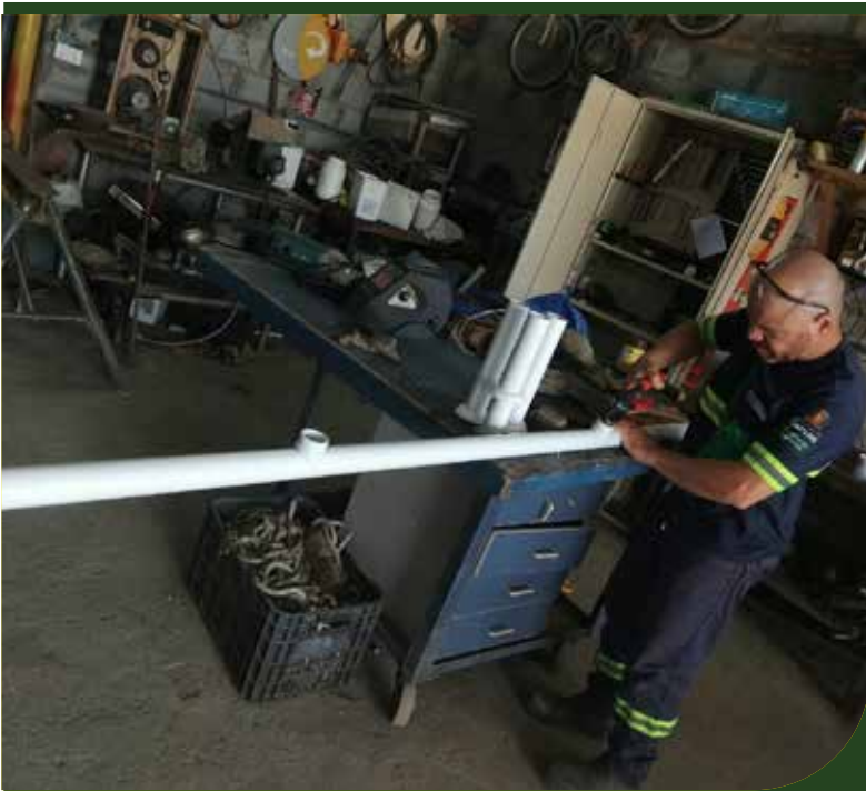
Concluída instalação de corrimão na unidade de ensino Noel Gomes
