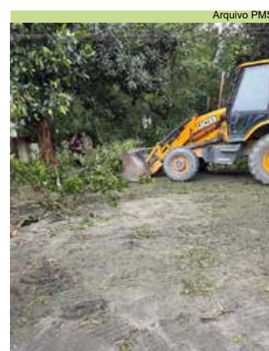
Realização de serviço de cata-treco, no Caruara
