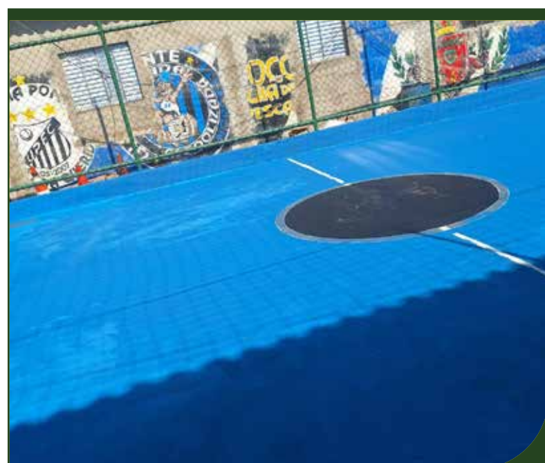
Continuação da pintura do piso e demarcações das linhas na quadra esportiva da Última Ponte, no Rádio Clube
