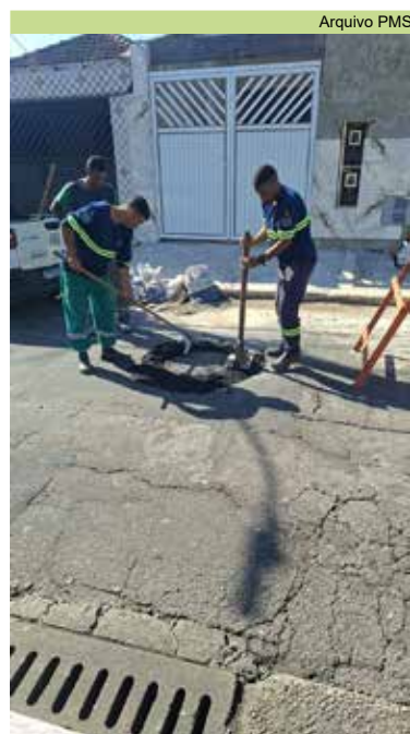
Reparos no entorno do poço de visita na Rua Mário Calmon de Brito, no Castelo
