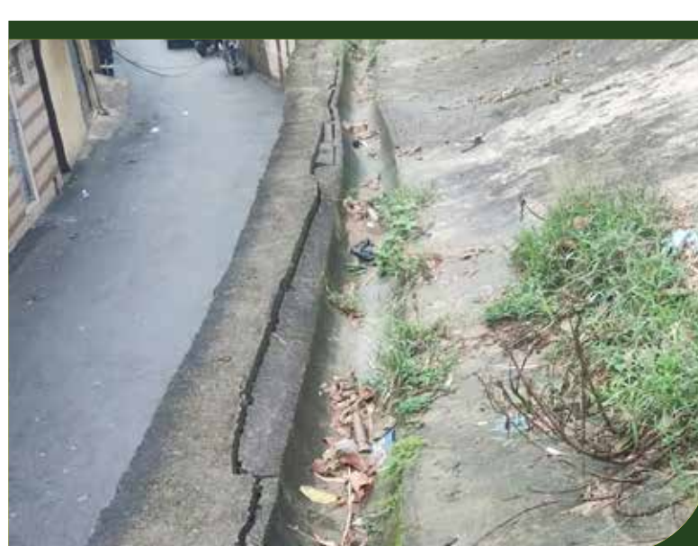
Serviço de limpeza de grelhas e canaletas na Rua 13, no Morro Santa Maria
