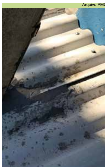
Reparo em telhado no Morro Cruzeiro
