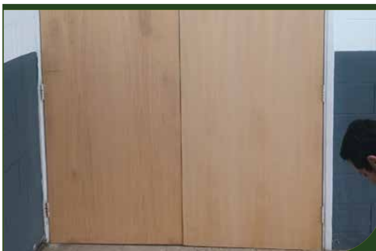
Troca de duas portas na sala de artes marciais no Ginásio Dale Coutinho
