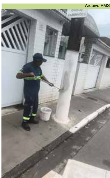
Pintura de postes na Rua Pedro Paulo Giovanni, no Santa Maria
