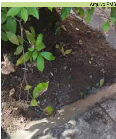
Abertura de berço e reparos na calçada na Rua Paraguai, no Gonzaga
