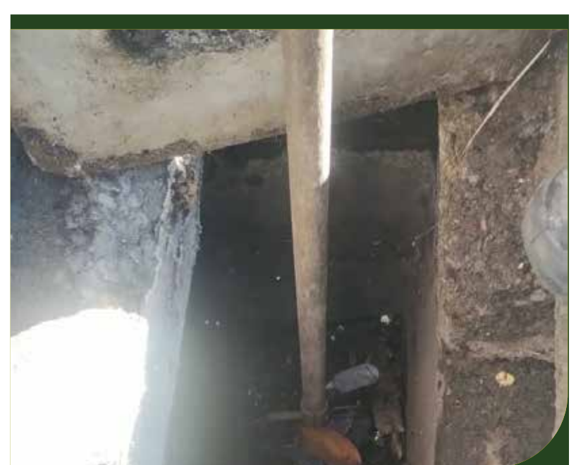
Limpeza de grelhas e caixas na Lagoa da Saudade, no Morro Nova Cintra
