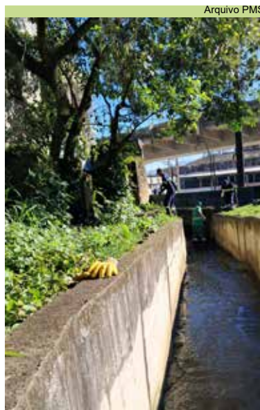
limpeza de canal no Complexo Marina Magalhães, no São Bento
