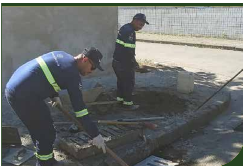
Troca e nivelamento de boca de lobo na Rua Pirajá da Silva, em frente ao número 286, na Aparecida
