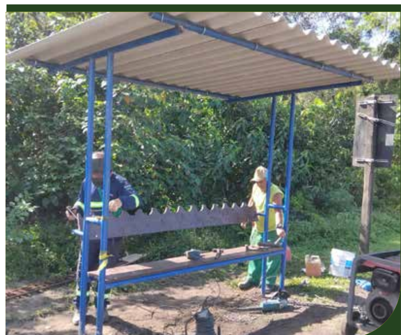
Instalação de ponto de ônibus ao lado da ponte no Monte Cabrão
