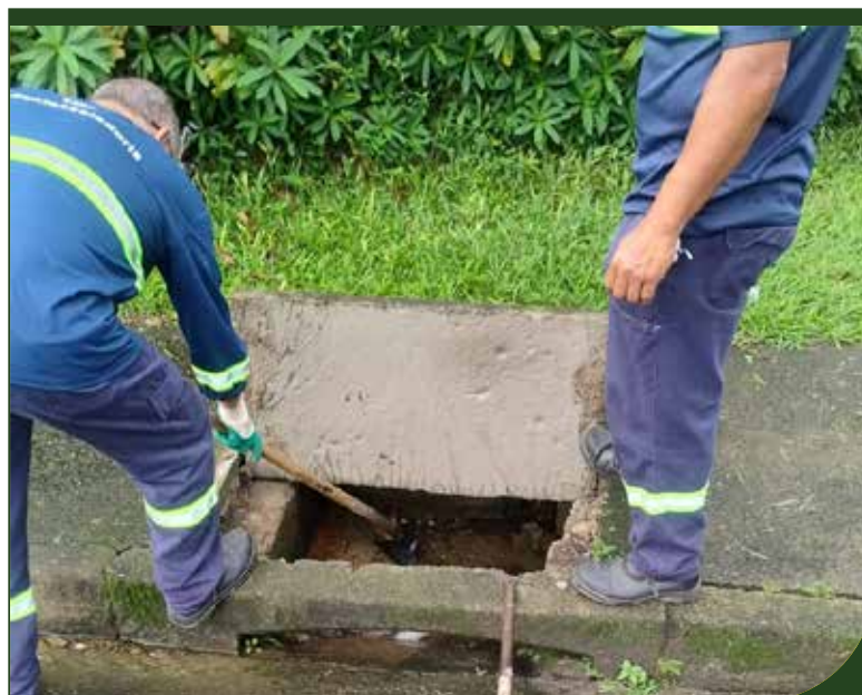
Limpeza de caixas de drenagem na Lagoa da Saudade, no Morro Nova Cintra
