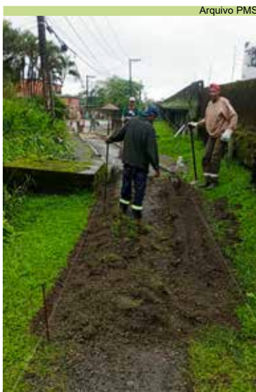
Construção de caminho com placas drenantes no Monte Cabrão
