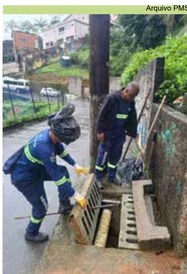
Limpeza de caixas na Rua Belchior Marques, no Morro Santa Maria
