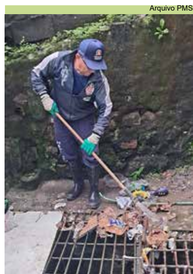
Serviço de limpeza de caixas na Rua Bandeirantes, na Vila São Bento
