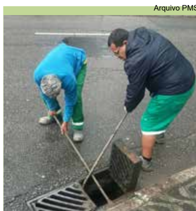
Abertura e limpeza de boca de lobo na Av. Cons. Nébias, no Boqueirão
