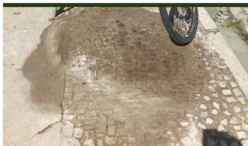
Reparo em piso mosaico na Rua Tolentino Filgueiras, no Gonzaga
