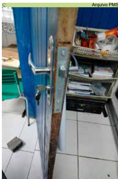
Substituição de fechadura na UME Monte Cabrão
