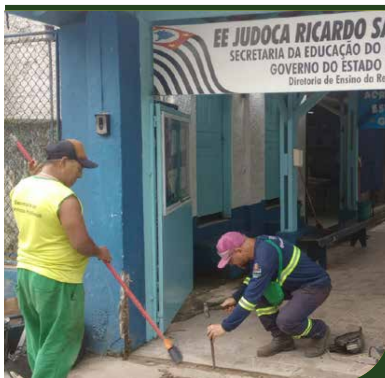
Zeladoria faz instalação de porta de contenção na UME Judoca Ricardo Sampaio
