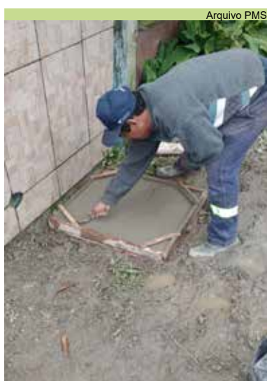
Concretagem de tampa da caixa de passagem na Rua Malvão
