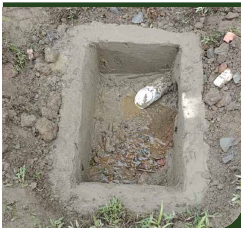
Reparos de caixa de passagem na Rua Caramuru, em frente ao número 56, no Caruara
