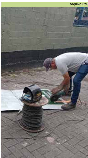
Soldagem do local da bomba d'água do CEU das Artes, na Praça da Paz Universal
