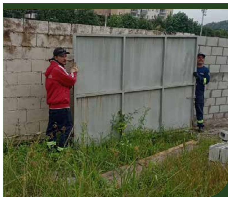
Retirada de portão no terreno entre os blocos A e B no Centro Cultural, no Sambódromo
