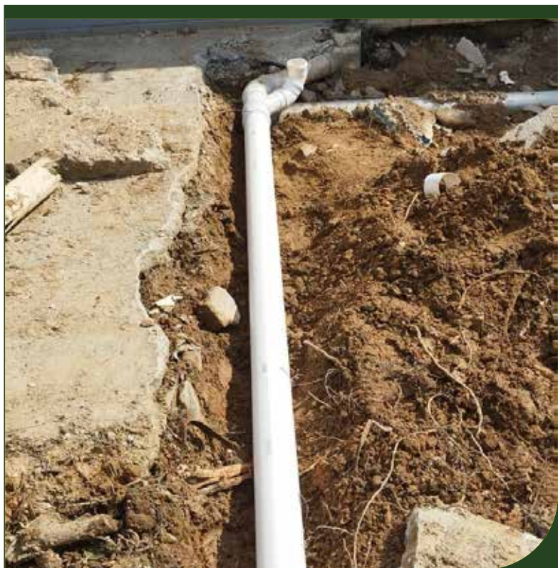
Instalação de tubulação de água pluvial na Avenida Doutor Frederico de Figueiredo Neiva, no Rádio Clube
