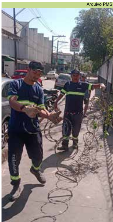
Chumbamento de hastes e colocação de concertinas no muro do CAPS, no Bom Retiro
