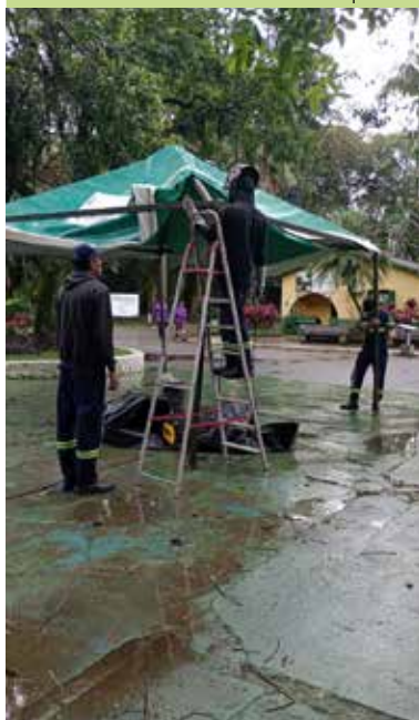
Soldagem de estrutura de tenda no Jardim Botânico
