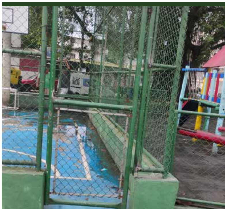
Portão instalado na quadra esportiva na Praça Professor Oswaldo Gonçalves Martins
