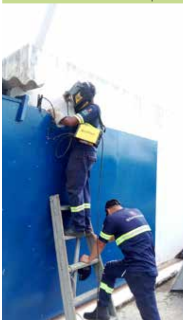
Soldagem de portão no Cemitério da Areia Branca
