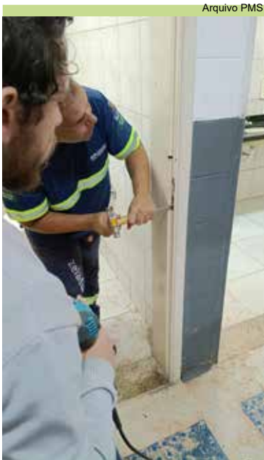
Instalação de porta no sanitário no Ginásio Dale Coutinho
