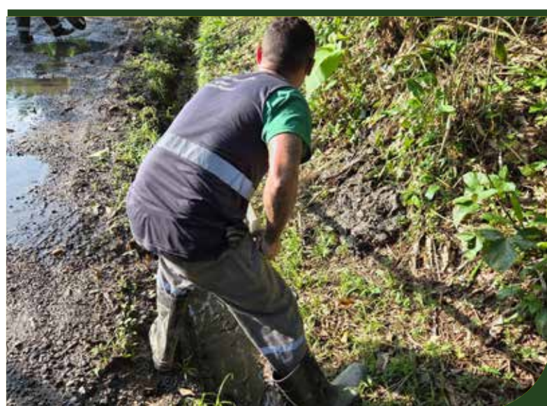
Limpeza e raspagem das canaletas na Rua Travessa Antônio Mineiro, no Caruara
