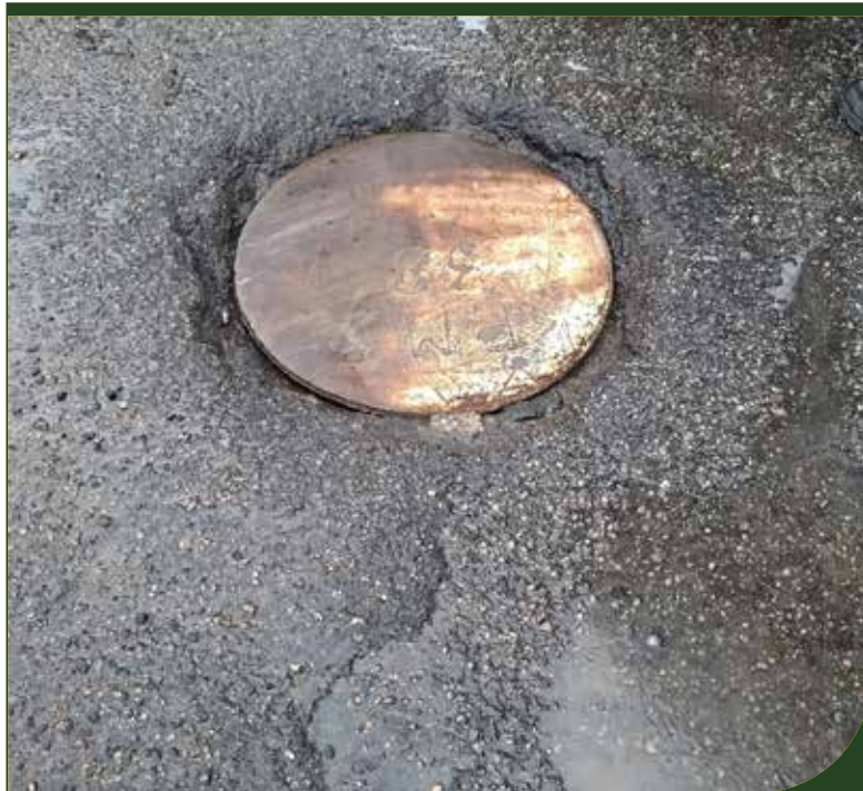
Colocação de chapéu chinês: Av. Vereador Alfredo das Neves com Rua João dos Reis Portela
