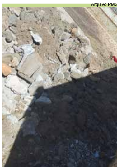
Retirada de entulho na Rua 2, no Morro Penha
