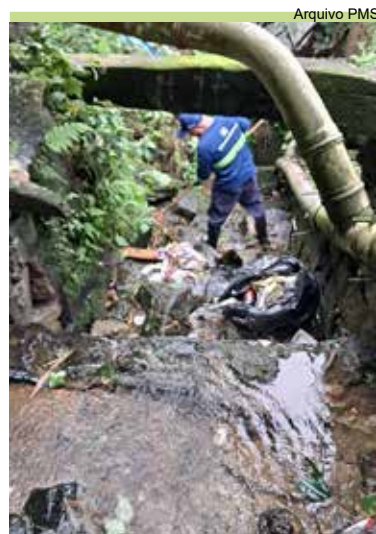
Limpeza de vala na Rua 4, no Morro Pacheco
