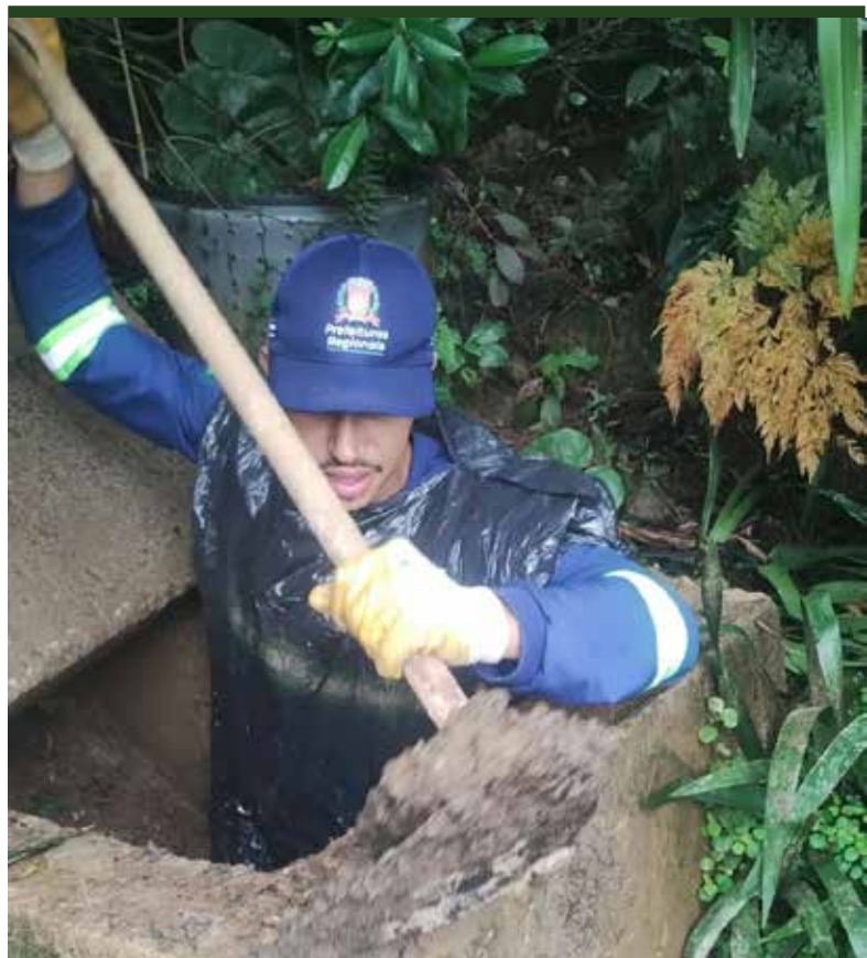
Limpeza de caixa de drenagem na Rua 1, no Morro Marapé
