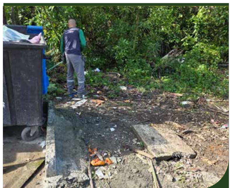
Limpeza e colocação de bica corrida no entorno de lixeiras no Caruara
