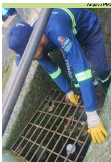
Limpeza de caixas, grelhas e escada hidráulica na Rua 9
