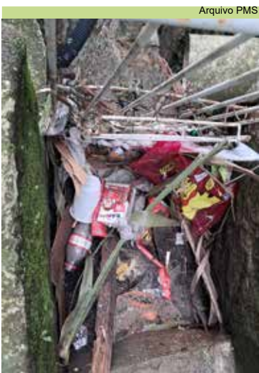
Limpeza de caixas, canaleta e escada hidráulica na Rua 12
