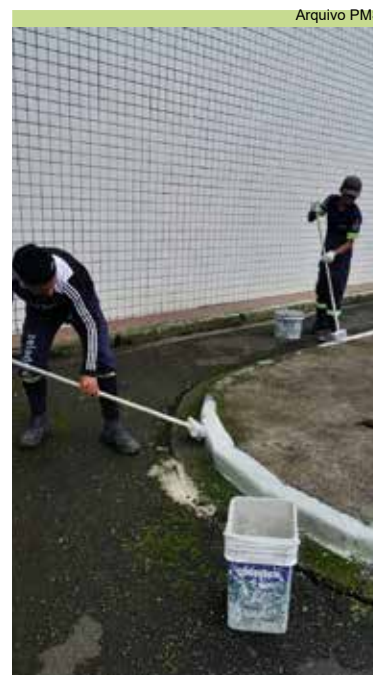
Pintura de guias na Rua 13, na Vila Pelé
