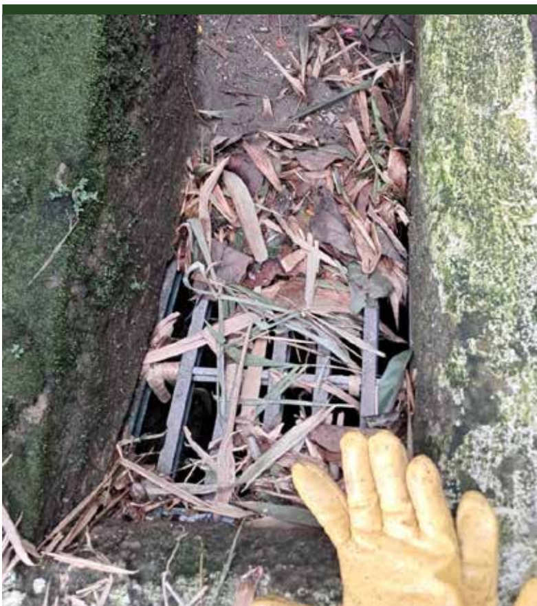
Serviço de limpeza de caixa e escada hidráulica na Rua 11, no Morro Pacheco
