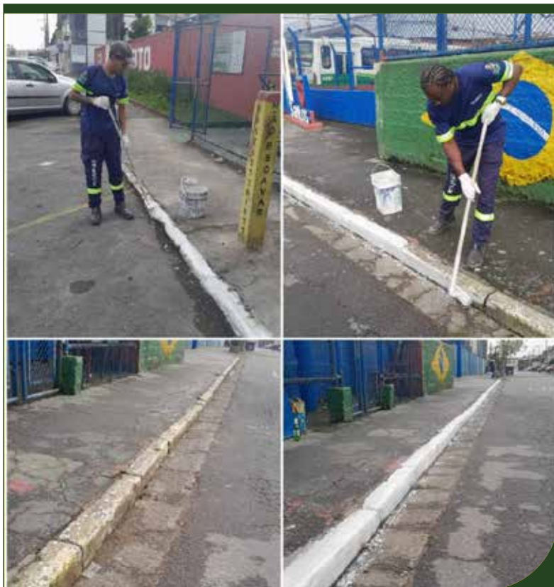
Pintura de guias na Rua 1, na Vila Pelé
