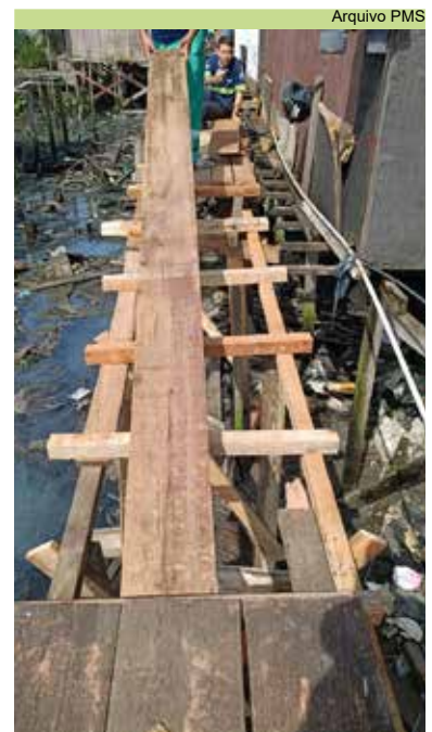
Reparo da passarela de madeira no Rádio Clube
