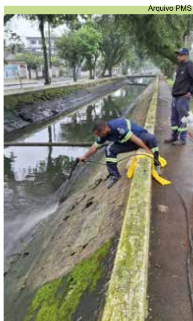
Serviço de limpeza no talude do canal da Avenida Eleonor Roosevelt
