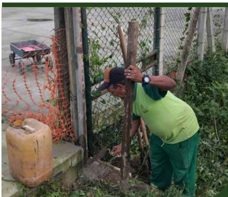
Fixação de tubo para a instalação de portão no alambrado da torre de internet
