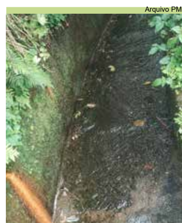
Serviço de limpeza de caixa e vala na Avenida Brasil, no Nova Cintra
