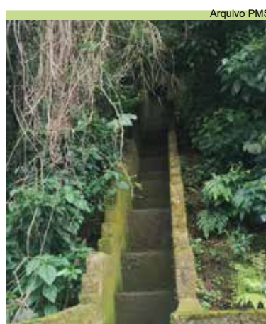
Limpeza de caixas e escada hidráulica na Rua Nilo Peçanha
