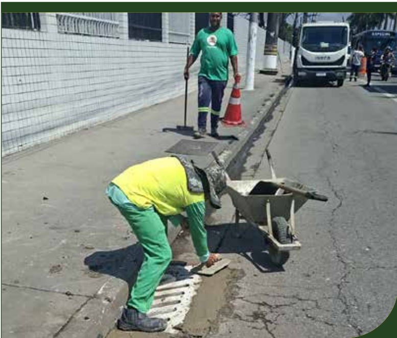
Troca de boca de lobo na Rua Doutor Pedro Paulo de Giovanni, no Santa Maria
