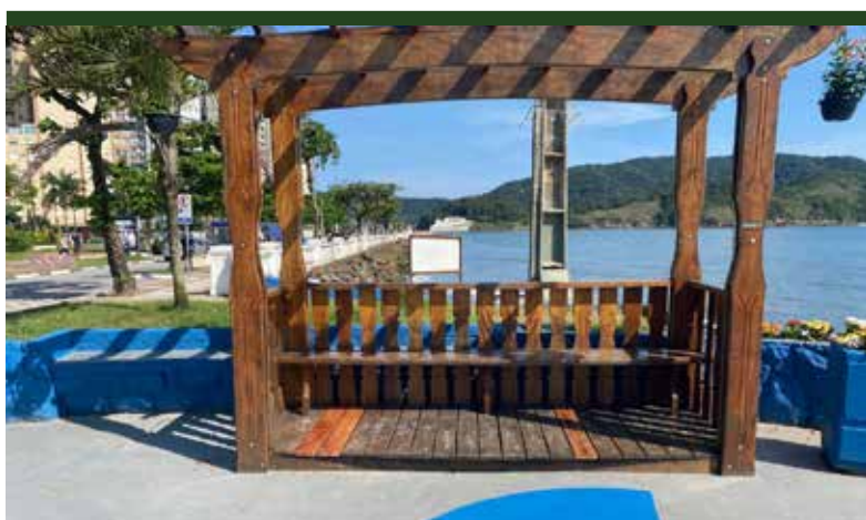
Conclusão da instalação de três pergolados na Praça do Aquário, na Ponta da Praia
