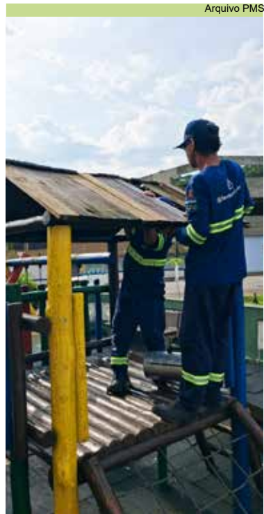
Realização de conserto de telhado da Casa do Tarzan
