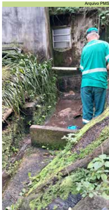
Limpeza de canaleta, caixa e córrego na Rua Brigadeiro Newton Braga
