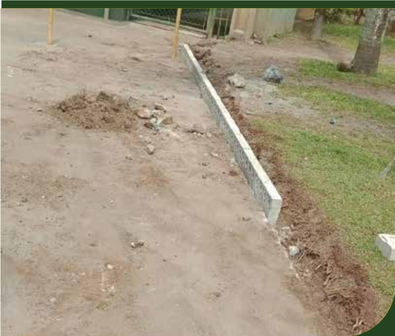
Retirada de calçada e troca de cordonel na Praça Encarnación Alves Corpas
