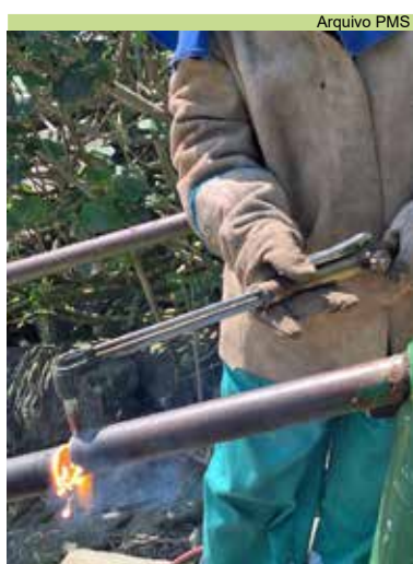
Reposição de tubo do corrimão do Emissário Submarino
