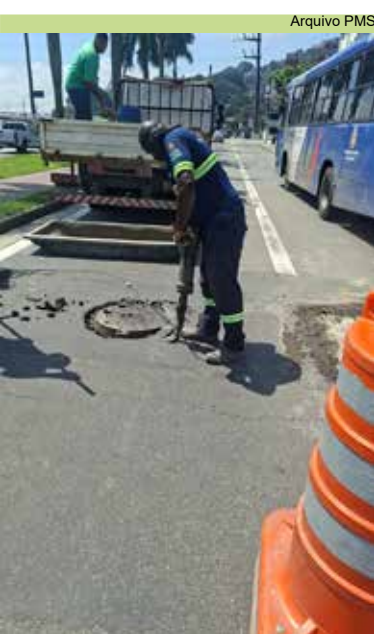
Instalação de poço de visita na Avenida Martins Fontes, no Saboó
