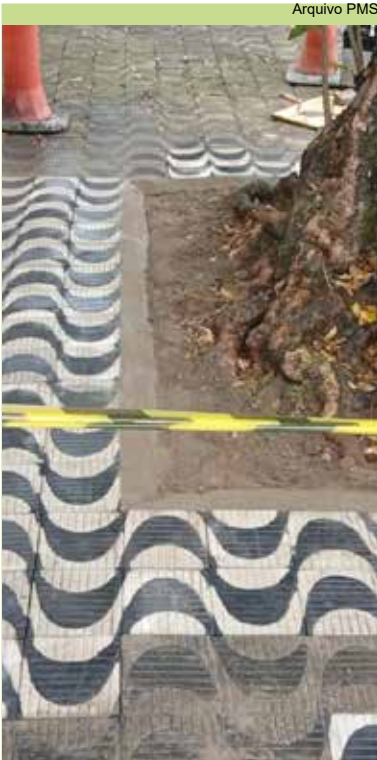
Abertura de berço e reparo em piso de calçada tipo Copacabana no Marapé
