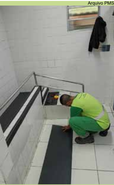
Instalação de tapete antiderrapante no banheiro de creche
