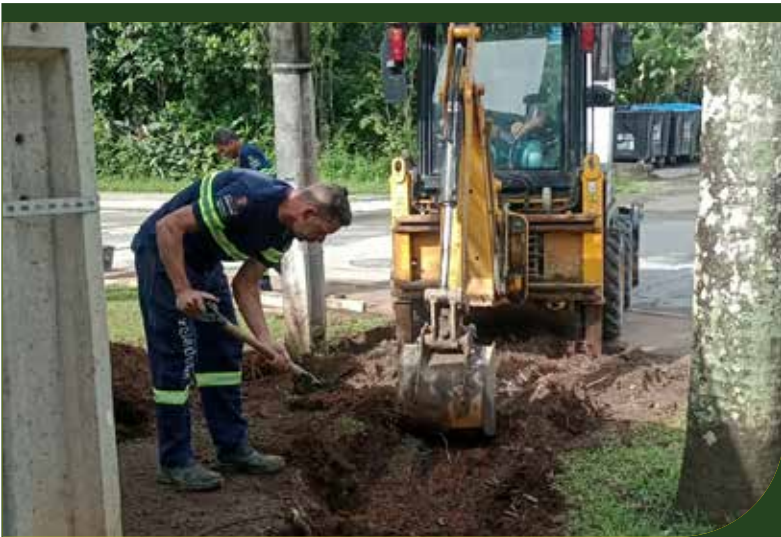
Instalação de cordonel na Praça Encarnación Alves Corpas, no Caruara
