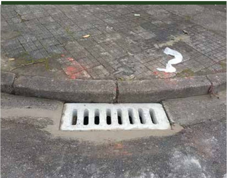
Reconstrução de paredes e troca de boca de lobo: ruas José Gonçalves da Mota Junior e 9 de Julho
