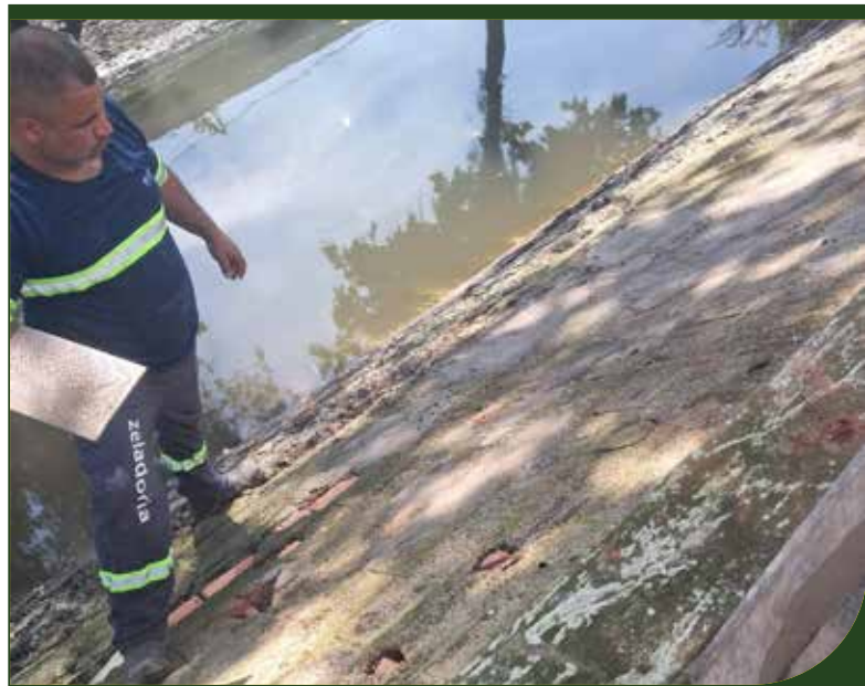
Reparos no talude do Canal da Avenida Eleonor Roosevelt, no São Jorge
