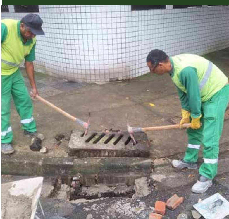
Conserto de boca de lobo na esquina das ruas Major Santos Silva com Frei Francisco Sampaio
