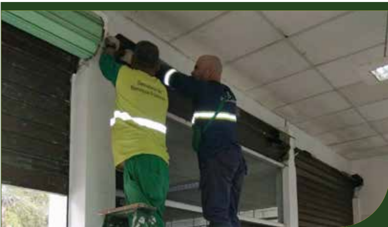
Manutenção e conserto de porta de aço na Vila Criativa
