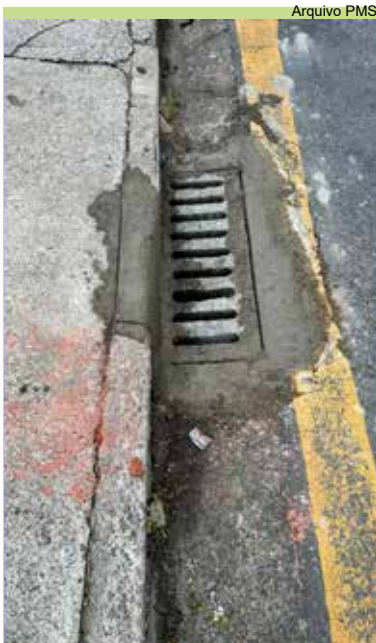
Conserto de boca de lobo na Praça Primeiro de Maio, na Ponta da Praia
