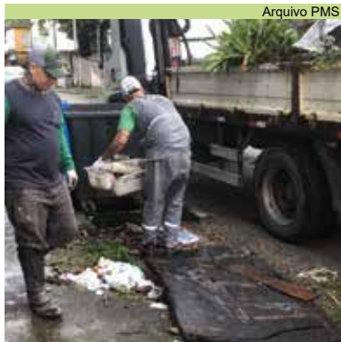
Realização de serviço de cata-treco no Caruara
