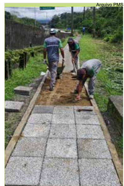
Colocação de piso drenante no acesso à Rodovia Cônego Domênico Rangoni, no Monte Cabrão
