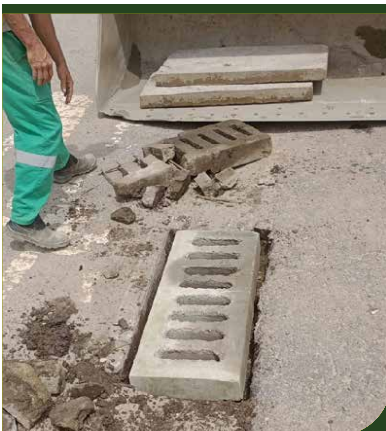
Substituição de grelha de boca de lobo na Rua Andrade Soares, em frente ao número 345, no Caruara
