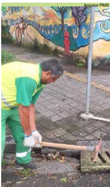
Limpeza de boca de lobo: Mons. Paula Rodrigues e Júlio Conceição
