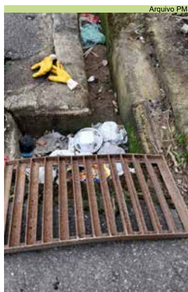
Limpeza de córrego, canaleta e caixas na Rua F, no Morro José Menino
