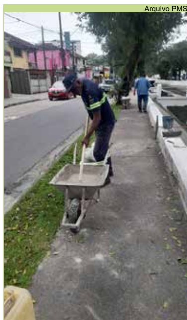
Reparo em buracos do talude do Canal 1
