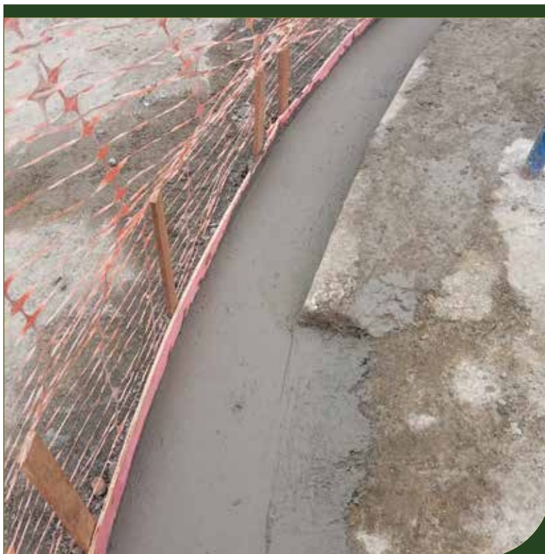
Finalizada concretagem em sarjeta no trecho Xavantes x Andrade Soares
