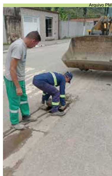
Feita troca de grelha na via Andrade Soares
