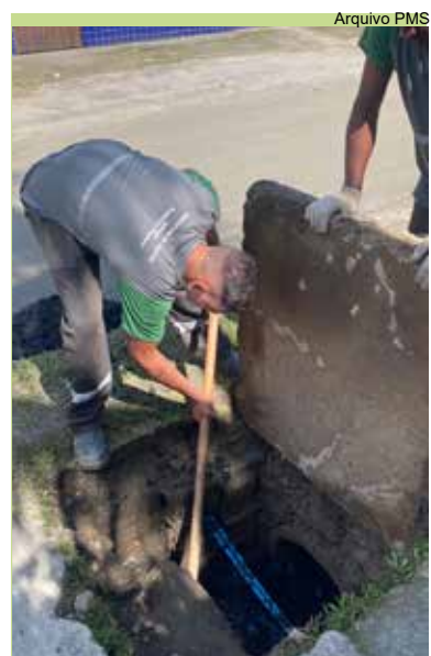
Zeladoria fez limpeza de caixas de drenagem das ruas Galvão e Particular A e D
