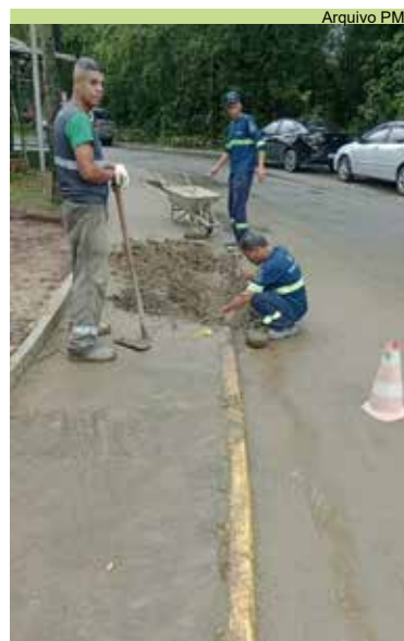
Instalação de guias na Praça Encarnacion Alves Corpaz
