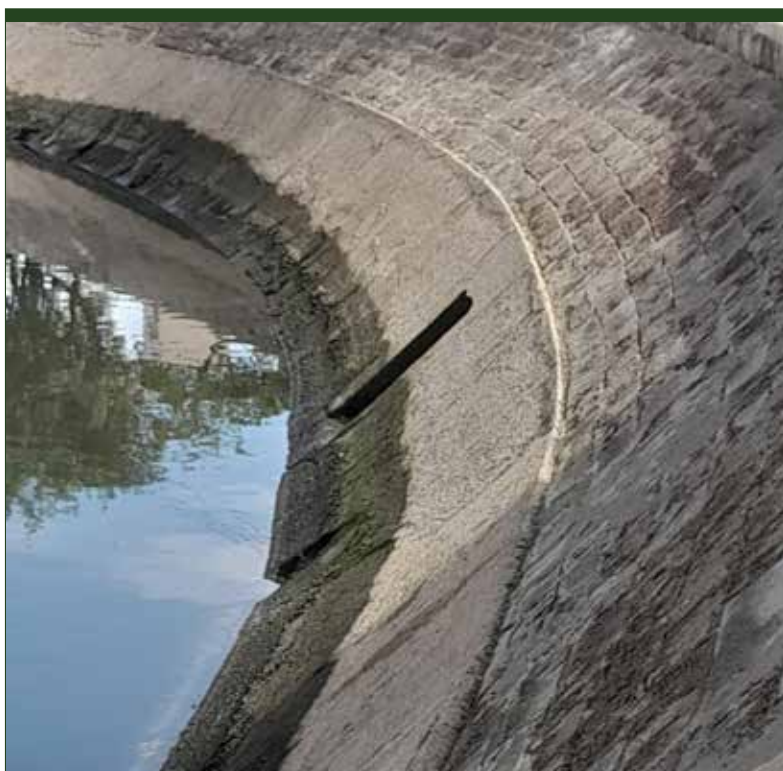
Feito reparo em talude do canal 1, altura do nº 532 da Avenida Pinheiro Machado
