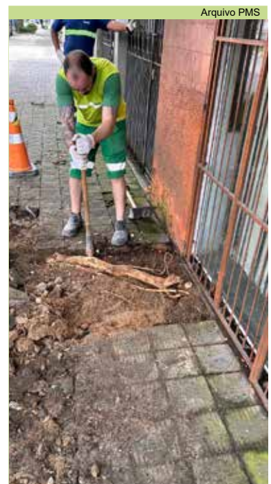
Zeladoria concluiu reparo em calçada da Av. Afonso Pena, 649
