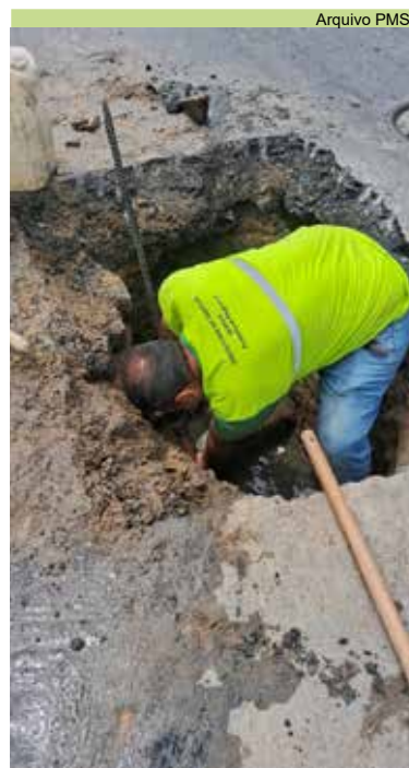
Finalizada intervenção em abatimento na Rua João Guerra, 185
