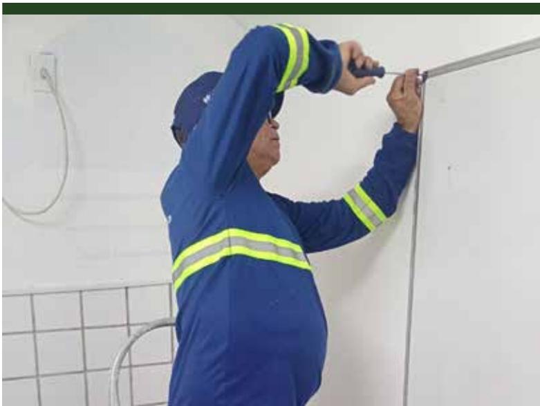
Zeladoria realizou instalação de quadro em próprio público
