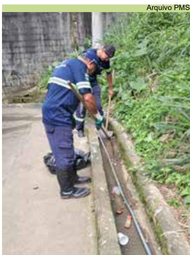
Equipe concluiu limpeza de canaletas na Rua Santa Inês
