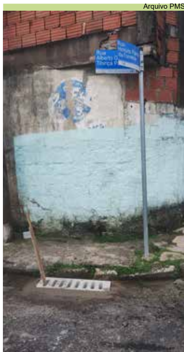
Nova boca de lobo instalada em trecho da Alberto Tibiriça e Honório Palma
