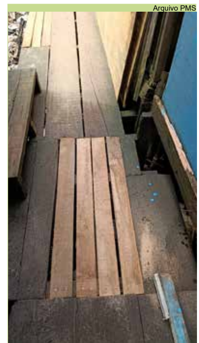
Concluído reparo na passarela do Caminho São Sebastião, nº 315.
