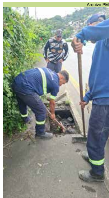
Feita troca de tampa na Avenida Martins Fontes, altura do numeral 1085
